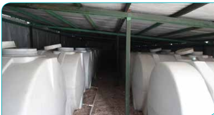
شکل ۲-۱۳- منبع‌های پلی اتیلنی در زیر سطوح شیب‌دار ایجاد شده در جزیره اشک (عکس از بهزاد شیر پنجه)
