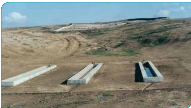
شکل ۲-۱۱- تصویری از آبشخورهای احداث شده که تأمین آب آنها از طریق سطوح آبیگر مصنوعی باران انجام می‌شود (عکس از قدوسی ۱۳۷۶)
