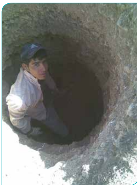
شکل ۳-۱۹- تصاویر حفر گمانه در نقطه UD-K-۱
