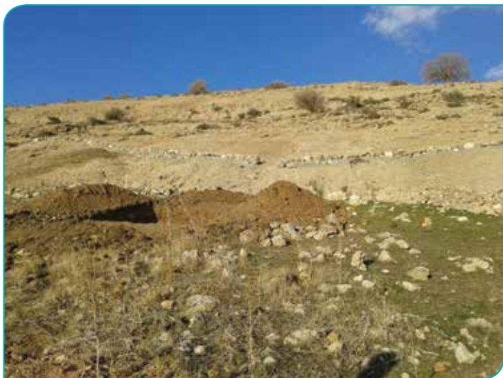
شکل ۵- پی‌کنی حوضچه رسوبگیر
