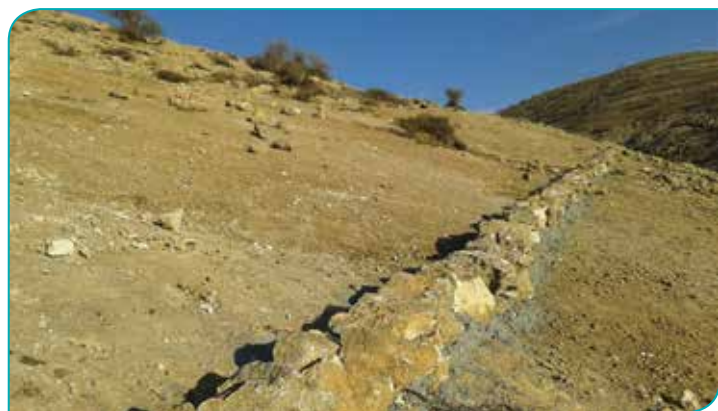
شکل ۳- احداث دیواره‌های سطوح آبگیر
